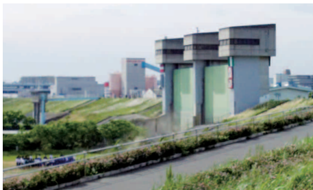
▲荒川の氾濫を防ぐためにつくられた三領水門。荒川に合流する菖蒲川の水を排水する
