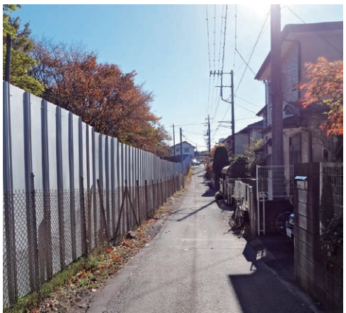
高さ3メートルのフェンスで覆われた自衛隊入間病院等の建設予定地
