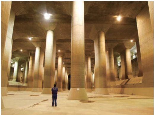
▲パルテノン神殿のような調圧水槽。地下は一年を通して気温10~20度
