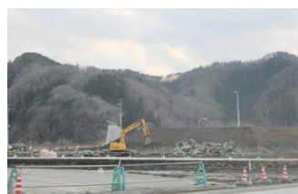
2015年9月完成をめどに進められている盛土工事。大槌町旧役場周辺
