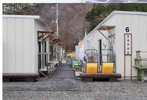
山間の不便な場所に建てられている仮設住宅
